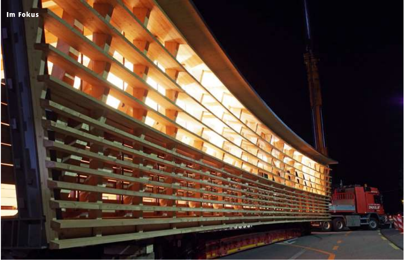
Der aufstrebende Schweizer Holzbau könnte noch vermehrt im Finanzmarkt wahrgenommen werden und dieser ihm neue Impulse verleihen. Bild: Warten auf die Montage – 30 Tonnen schwere Holzbrücke über die Autobahn bei Rubigen BE. Foto: Martin Binkert
