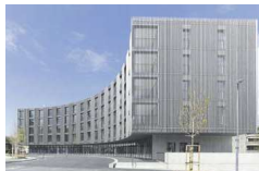
Johnsonhaus, Köniz, www.timbatec.ch
